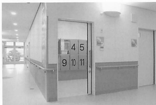
鉛遮へいパスボックス
