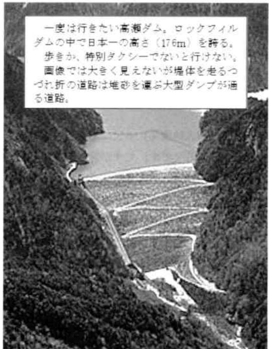
一度は行きたい高瀬ダム。ロックフィルダムの中で日本一の高さ（176m）を誇る。歩きか、特別タクシーでないといけない。画像では大きく見えないが堤体を走るつづれ折の道路は堆砂を運ぶ大型ダンプが通る道路。
