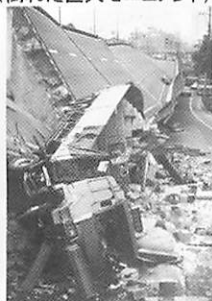
高速道路(倒れた巨大モニュメント)
