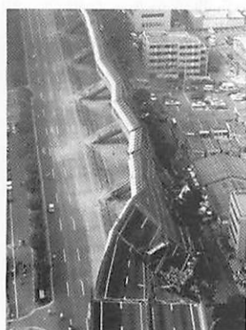
倒壊した高速道路
